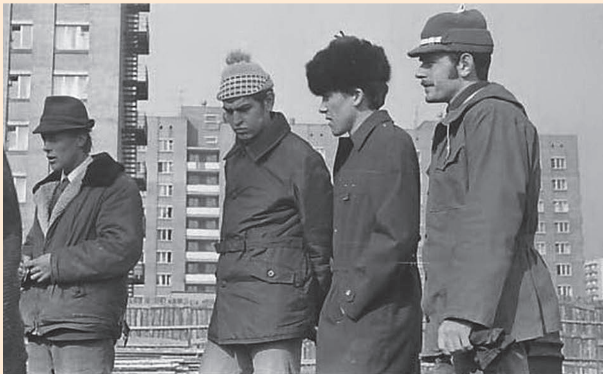
Начало строительства Северного студгородка ВГУ (конец 1970-х годов)
