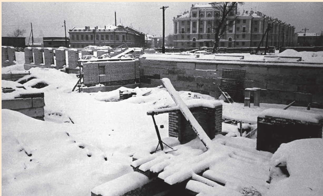
Идёт строительство главного корпуса, конец 1950-х – начало 1960-х годов
